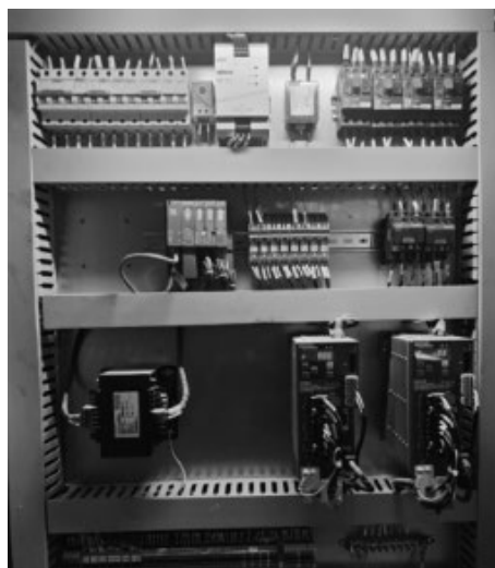
图5 控制箱内部结构
